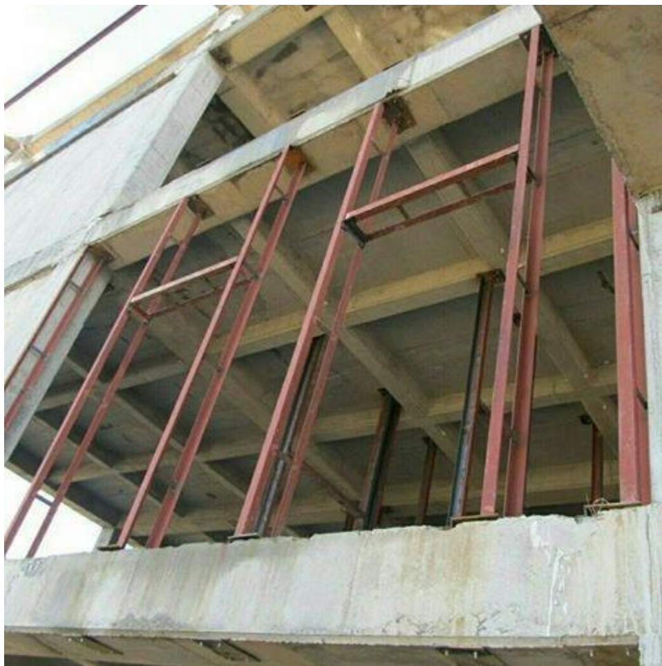
شکل ۶ ساخت به روش دیوار غیر میانقاب
